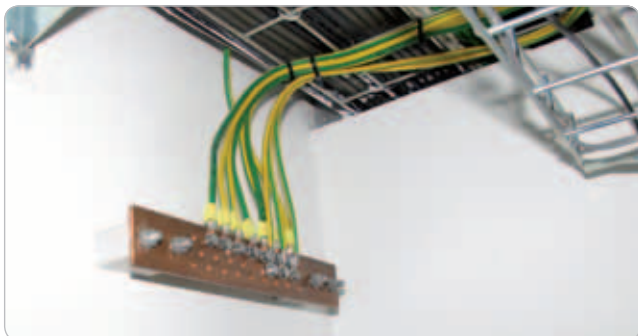
Obr. 3 Prípojnice pospájania na jednotlivých technologických podlažiach
