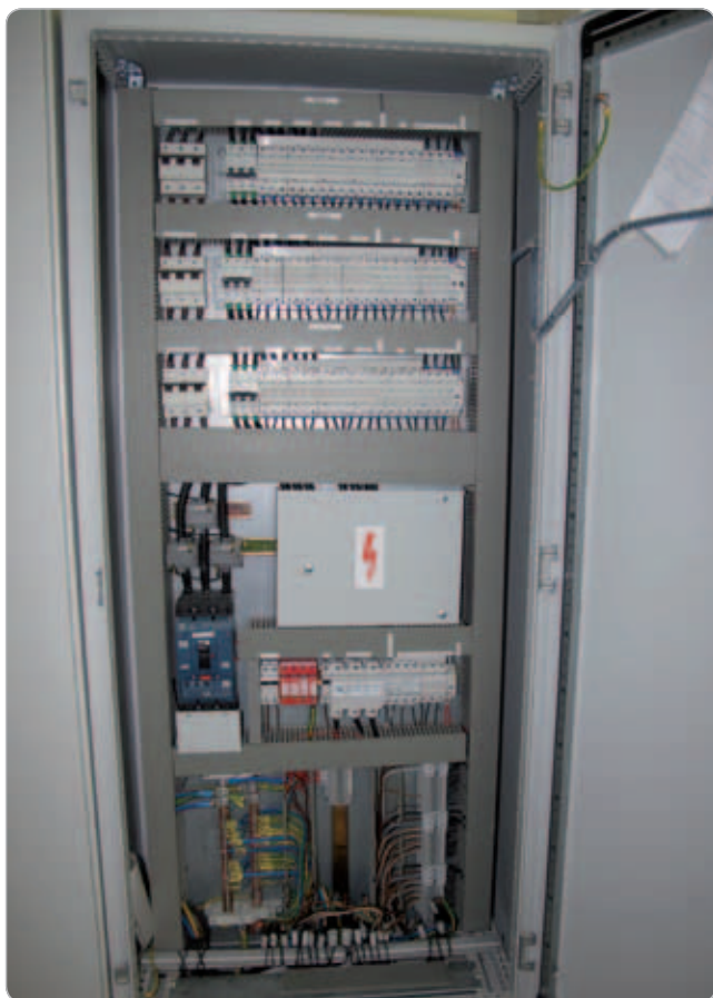
Obr. 6 Zvodnice prepätia typ 2 v podružnom rozvádzači
