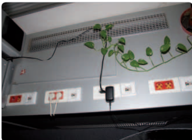
Obr. 7 Najjemnejšie ochrany typu 3 na vstupoch citlivých technologických modulov
