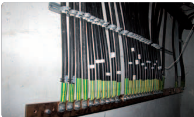
Obr. 2 Hlavná prípojnica pospájania
